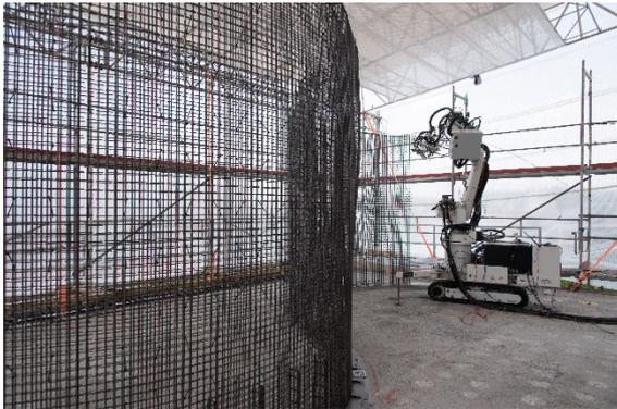
Der Beton wird in das Stahldrahtgitter eingegossen. Dank der engmaschigen Struktur des Stahldrahtgitters und der speziellen Betonmischung bleibt der Beton innerhalb des Gitters und fließt nicht heraus, was zu weniger Bauabfällen führt.
