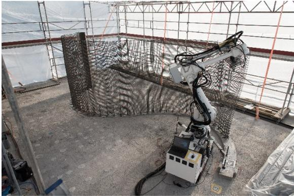
Der Bauroboter «In situ Fabricator» baut mithilfe der «Mesh Mould»-Technologie ein Stahldrahtgitter im Forschungsgebäude NEST. Die «Mesh Mould»-Technologie kombiniert die beiden Funktionen Schalung und Bewehrung des Betons in einem Stahldrahtgitter. Die Fertigung einer Wand geschieht in einem einzigen von Robotern kontrollierten Prozess.
