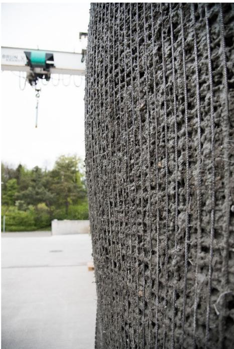
Nahaufnahme des Prototyps einer «Mesh Mould»-Wand. Das engmaschige von Robotern gebaute Stahldrahtgitter wird manuell mit Beton gefüllt.
